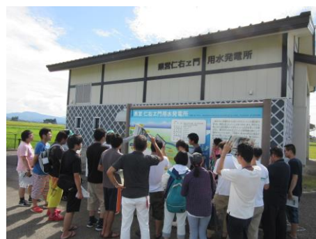
仁右エ門小水力発電所
