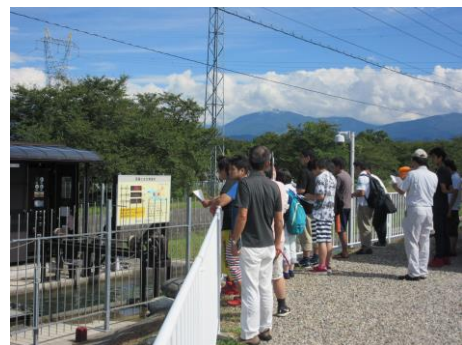
西番小水力発電所
