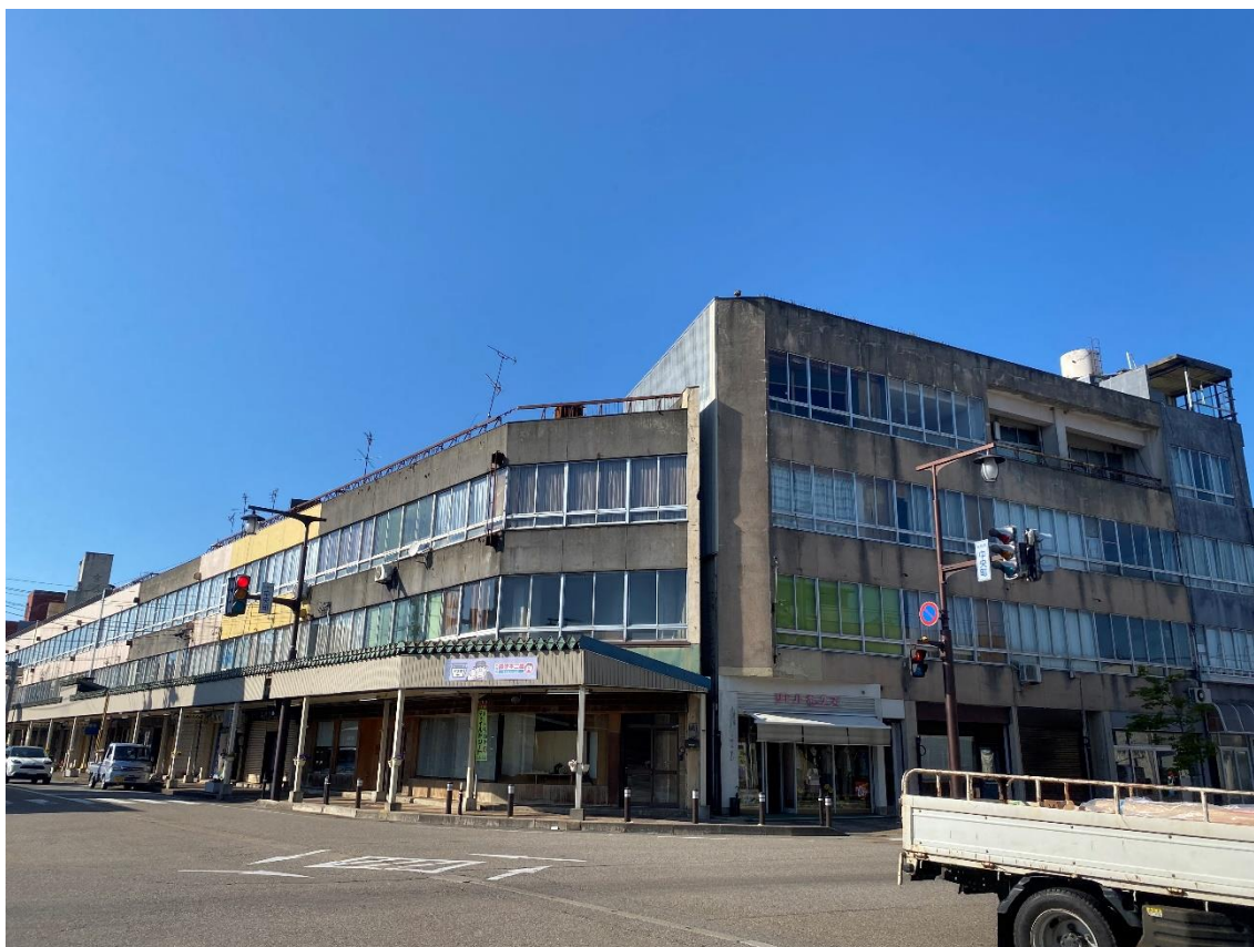
写真 氷見市中央町商店街の防災共同ビル
